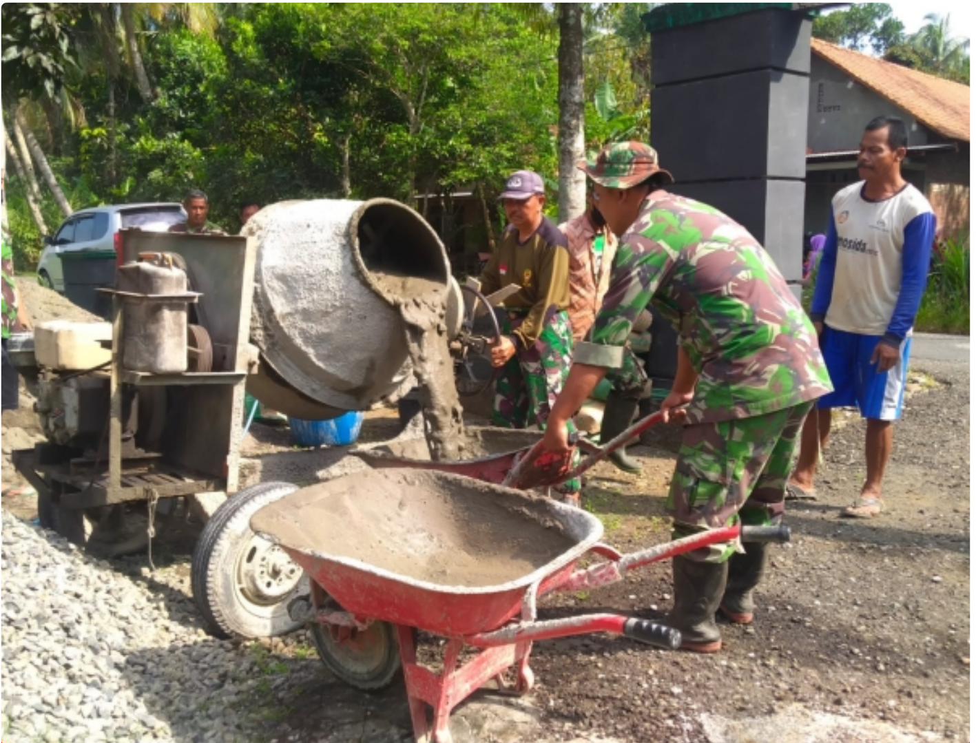
Anggota Posramil Bonorowo Bantu Warga Pengecoran Jalan
