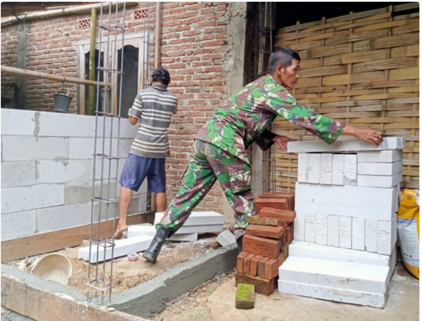
Peduli Warga Binaan, Babinsa Sampang Bantu Pembuatan Jamban
